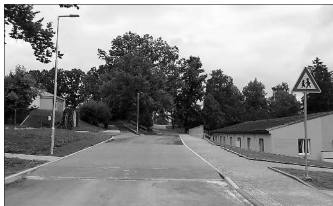
Rekonstrukce vozovky v lokalitě Za školou
