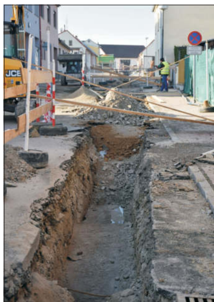
Ulice F. Sládka – průběh rekonstrukce ↗
