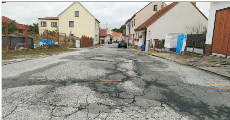
Ulice F. Sládka – před rekonstrukcí
