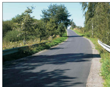
Opravená silnice mezi Řůžovem a Ledenicemi
