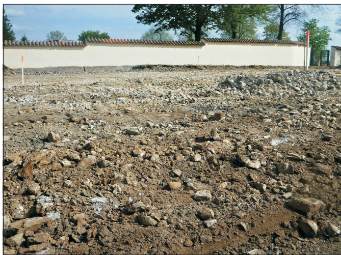
Oprava parkoviště u hřbitova
