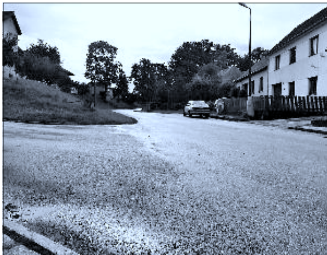
V týdnu před ledenickou poutí proběhlo frézování starého asfaltu a následná pokládka nové vrstvy asfaltu v části ulice 5. května v Ledenicích a to nákladem bezmála 500.000 Kč
