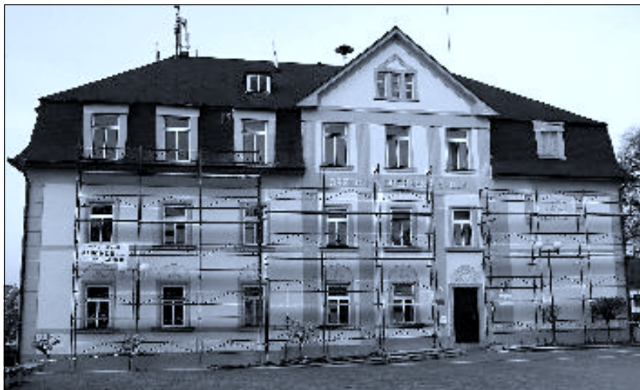
Hlavní budova školy – částečná oprava fasády – provádí firma KOMI-CB
