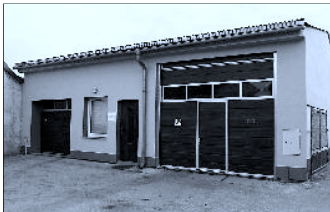
Na budově údržby městyse Ledenice došlo k výměně vrat – firma PALA ČB v.o.s.
