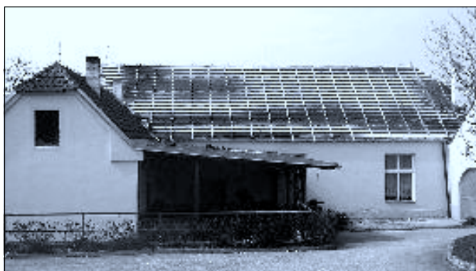
V Zalinech se pracuje na opravě kapličky. Firma KOMI-CB s. r. o. provádí izolaci stěn pomocí technologie infuzních clon a firma pana Kovačičína z Č. Budějovic připravuje statické zajištění vnitřních i vnějších vertikálních trhlin nad okny kaple
