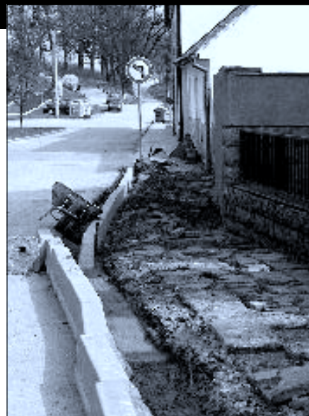
Oprava chodníku ve školní ulici v Ledenicích. Prováděla firma p. Šimčíka z Ledenic
