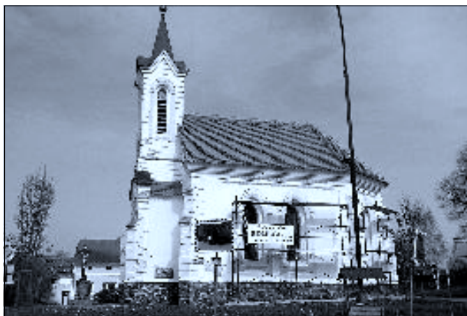
V Zalinech se pracuje na opravě kapličky. Firma KOMI-CB s. r. o. provádí izolaci stěn pomocí technologie infuzních clon a firma pana Kovačičína z Č. Budějovic připravuje statické zajištění vnitřních i vnějších vertikálních trhlin nad okny kaple
