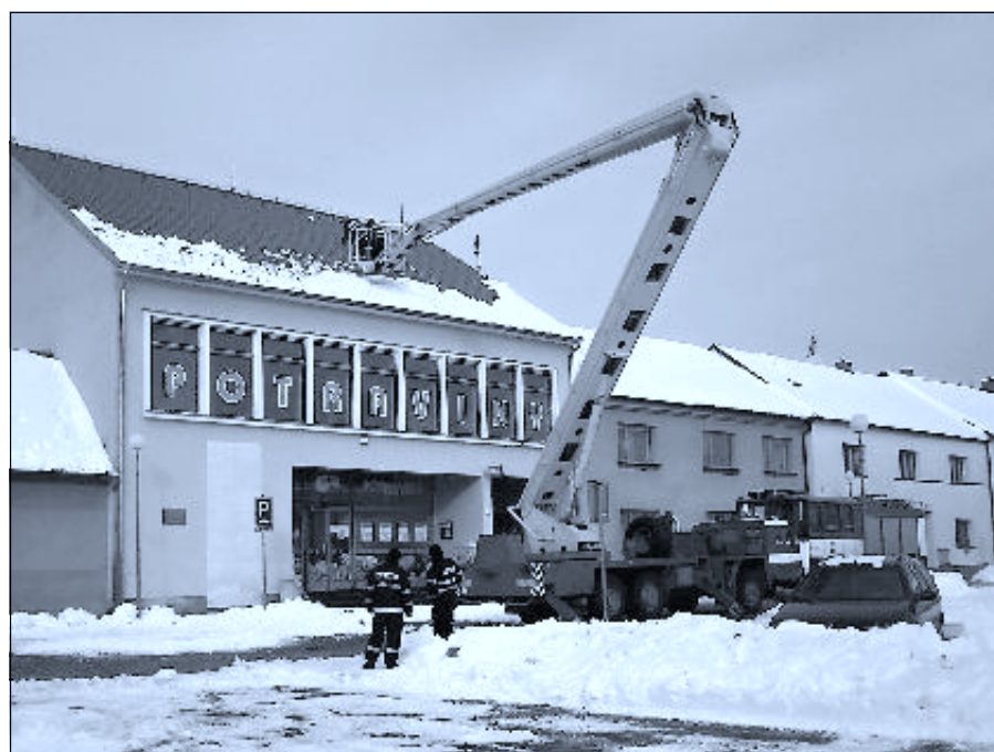
Dne 23. ledna zasahovali hasiči z Borovan a Č. Budějovic v Ledenicích. Padající sníh ze střechy prodejny potravin Trefa ohrožoval kolemjdoucí.
