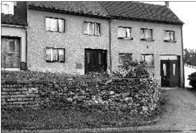
V měsíci květnu byl opraven rozpadající se kamenný taras u silnice Dr. Stejskala.
