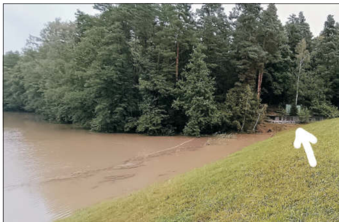
Retenční nádrž Kačerovec – k odtoku vody přes bezpečnostní betonový přeliv tentokrát chybělo ještě hodně vody
