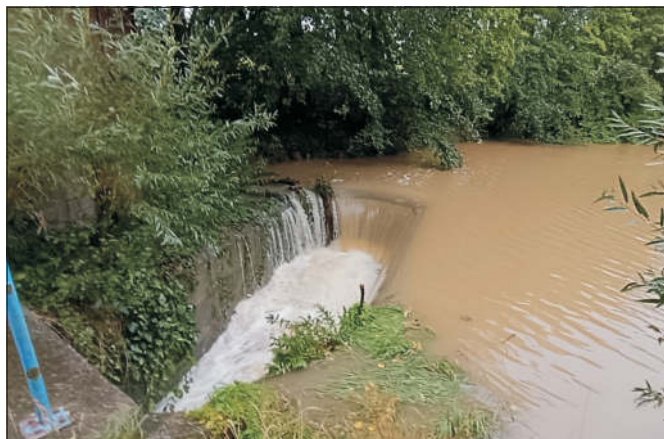
Retenční nádrž Slavíček zachycuje vodu z obtokového kanálu. Vodou byla zcela naplněna
